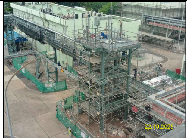
ข) กิจกรรมการติดตั้ง Regeneration Gas Compressor เพิ่มเติม จำนวน 2 ชุด
