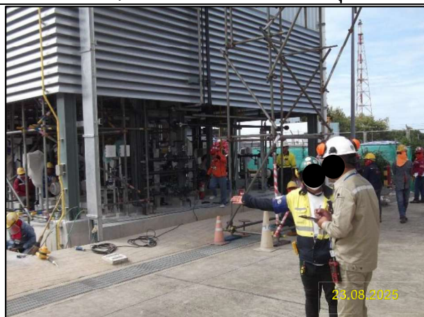
ง) กิจกรรมการติดตั้งหน่วยบำบัดน้ำทิ้งด้วยโอโซน (Advanced Oxidation Process; AOPs) เพิ่มขึ้น 1 หน่วย รูปที่ 1-6 ตัวอย่างการดำเนินงานของโครงการประจำเดือนสิงหาคม พ.ศ. 2568
