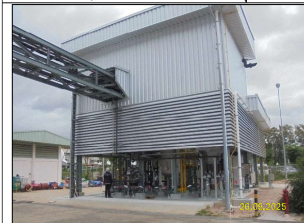
ง) กิจกรรมการติดตั้งหน่วยบำบัดน้ำทิ้งด้วยโอโซน (Advanced Oxidation Process; AOPs) เพิ่มขึ้น 1 หน่วย (งานทดสอบระบบ)
