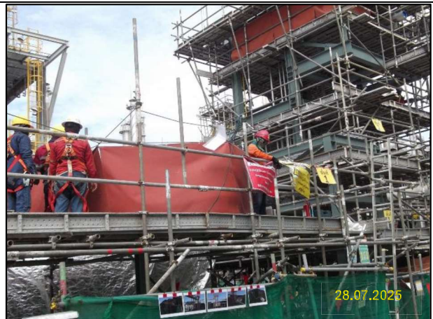
ง) กิจกรรมการติดตั้งหน่วยบำบัดน้ำทิ้งด้วยโอโซน (Advanced Oxidation Process; AOPs) เพิ่มขึ้น 1 หน่วย รูปที่ 1-5 ตัวอย่างการดำเนินงานของโครงการประจำเดือนกรกฎาคม พ.ศ. 2568
