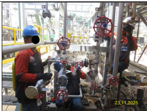
ข) กิจกรรมการติดตั้ง Regeneration Gas Compressor เพิ่มเติม จำนวน 2 ชุด (งานทดสอบระบบและงานปรับสภาพพื้นที่)
