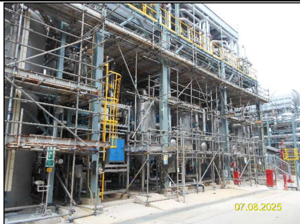
ก) กิจกรรมการติดตั้งหน่วยกำจัดกลิ่นแบบอาร์ทีโอ (Regenerative Thermal Oxidizer; RTO) และ SO 2 Scrubber
