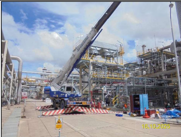
ข) กิจกรรมการติดตั้ง Regeneration Gas Compressor เพิ่มเติม จำนวน 2 ชุด
