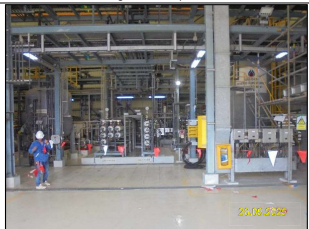
ง) กิจกรรมการติดตั้งหน่วยบำบัดน้ำทิ้งด้วยโอโซน (Advanced Oxidation Process; AOPs) เพิ่มขึ้น 1 หน่วย (งานทดสอบระบบ)
